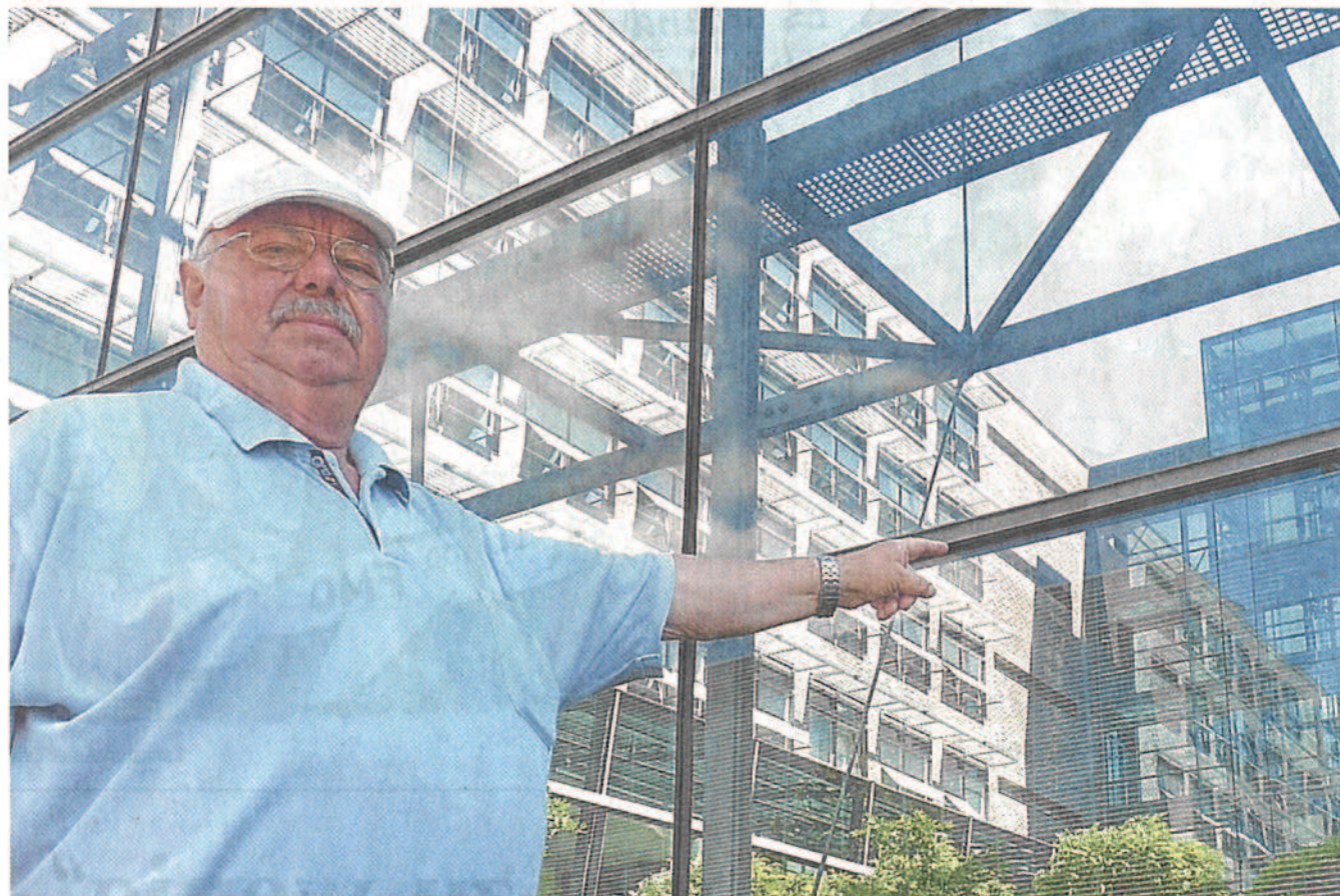
Peter Hlubek, Vorsitzender des Naturschutzbundes, zeigt auf die Glasfassade der Stadtwerke, die für Vögel in der Vergangenheit eine tödliche Falle war. Jetzt dienen ihnen für Menschen kaum sichtbare Linien als Warnung. Foto: da
